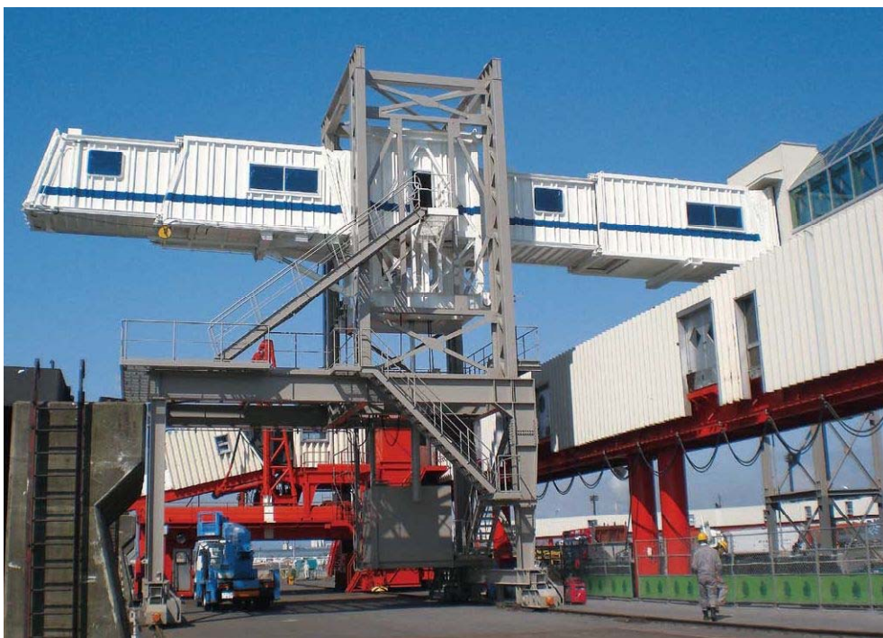
苫小牧港人道橋(ギャングウェイ装置) Passenger boarding bridge at Port of Tomakomai (Gangway system)
